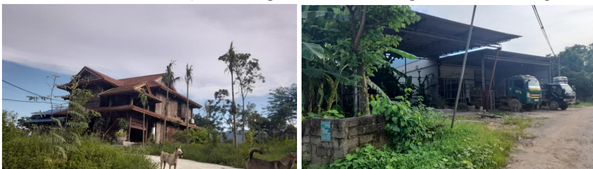
Một số hình ảnh công trình kiến trúc hiện trạng
